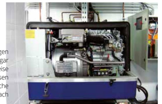
Dieser dreiphasige Generator ist im Untergeschoss installiert. Hauptsicherungen, Bedienpanel und Kühlersteuerung sind im Schaltschrank enthalten. Bild: Kratos Kft. Ungarn.
